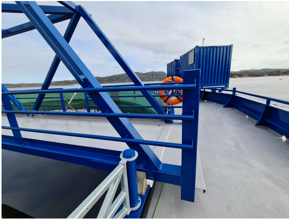
Figur 30: Bro, gangbane og containere med blant annet elektroutstyr på Aquatraz 2
