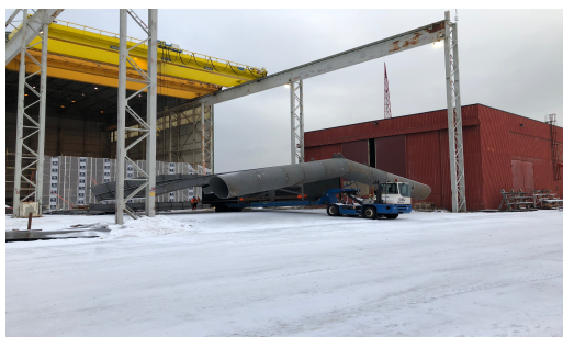
Figur 12: Transport av moduler
