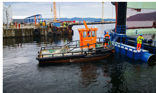
Figur 15: Fylling av dokk og forflytning av merdmoduler
